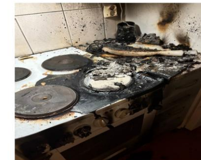
Kuva 1 Palo on ollut niin voimakas, että se on sulattanut seinässä olevan pistorasian.
